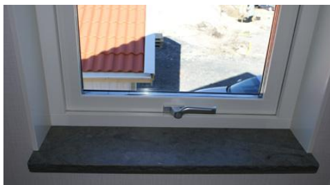
Vitmålade H-fönster med trippel isolerruta. Elit Super Energi. Standard fönsterbänk kalksandsten grå nr 3 slipad.
