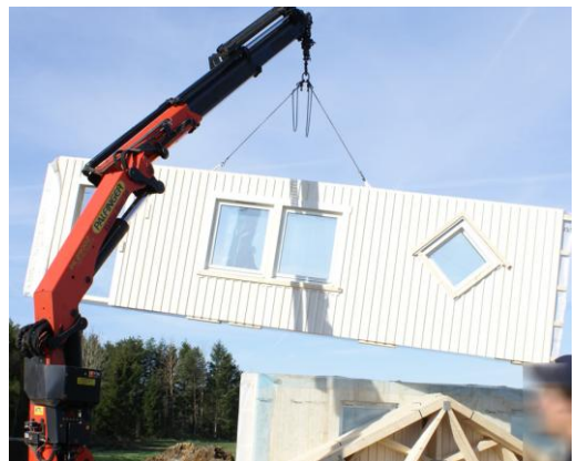
Väggblocken tillverkas upp till 8,5 m långa. Fönster och fönsterdörrar monteras i blocken.
